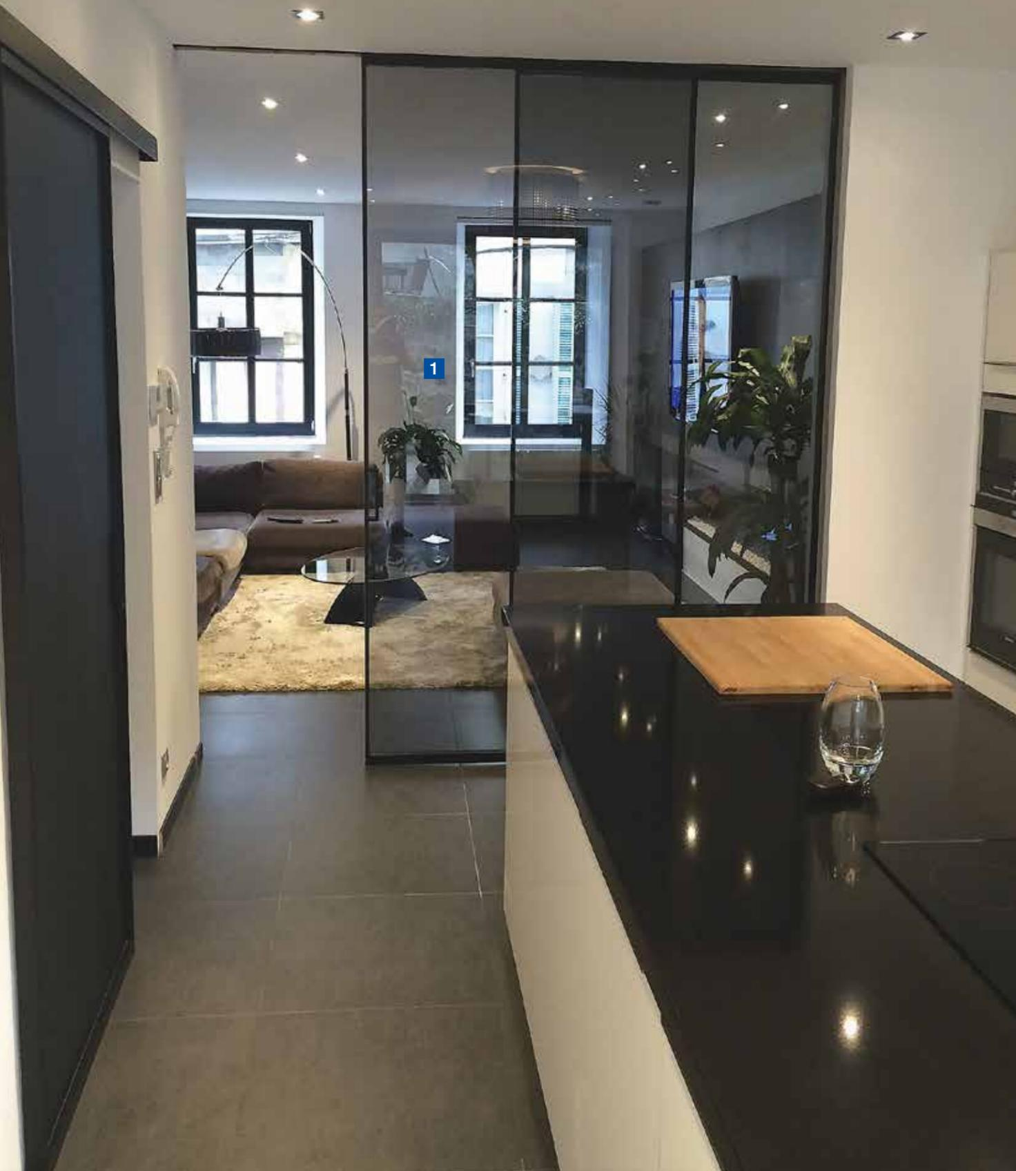
1 Châssis Syntesis® Line pour porte coulissante sans habillage. Épaisseur de cloison : 125 mm. 2 Porte verre & alu avec verre trempé extraclair et profil Marte argent opaque. Largeur de porte : 93 cm. Hauteur de porte : 2,04 m.
