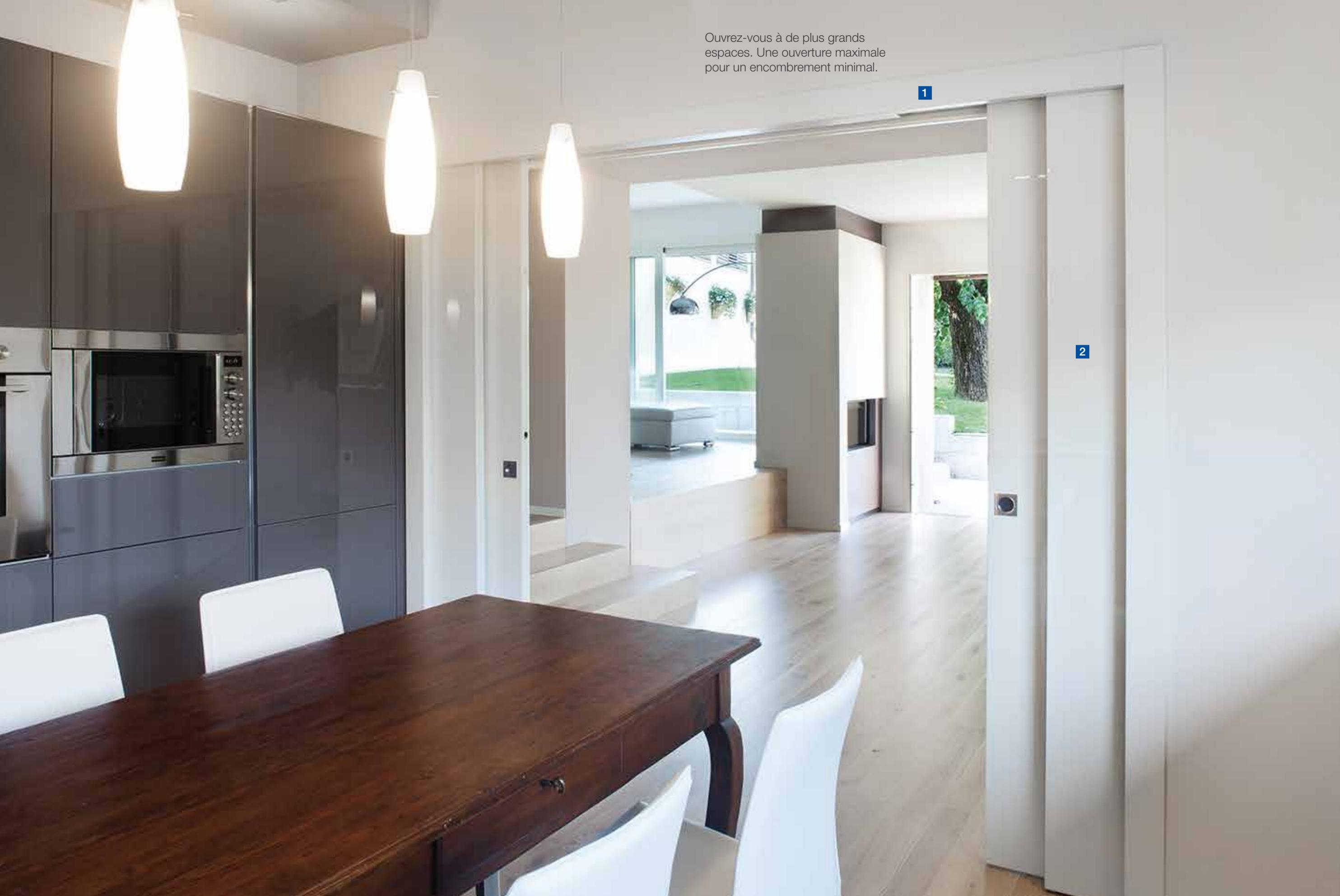
1 Châssis Télescopique Extension pour deux doubles portes coulissantes parallèles. Épaisseur de cloison : 180 mm.
